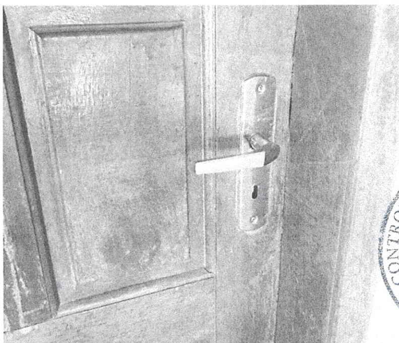
Foto 20- Colocação de fechadura
