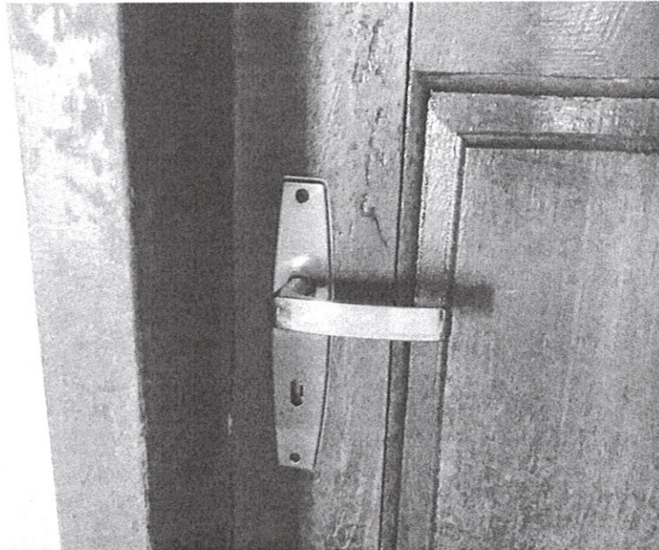
Foto 21- Colocação de fechadura
