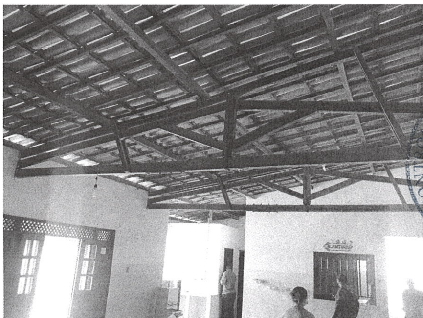
Foto 02- Revisão em Cobertura de telha cerâmica
