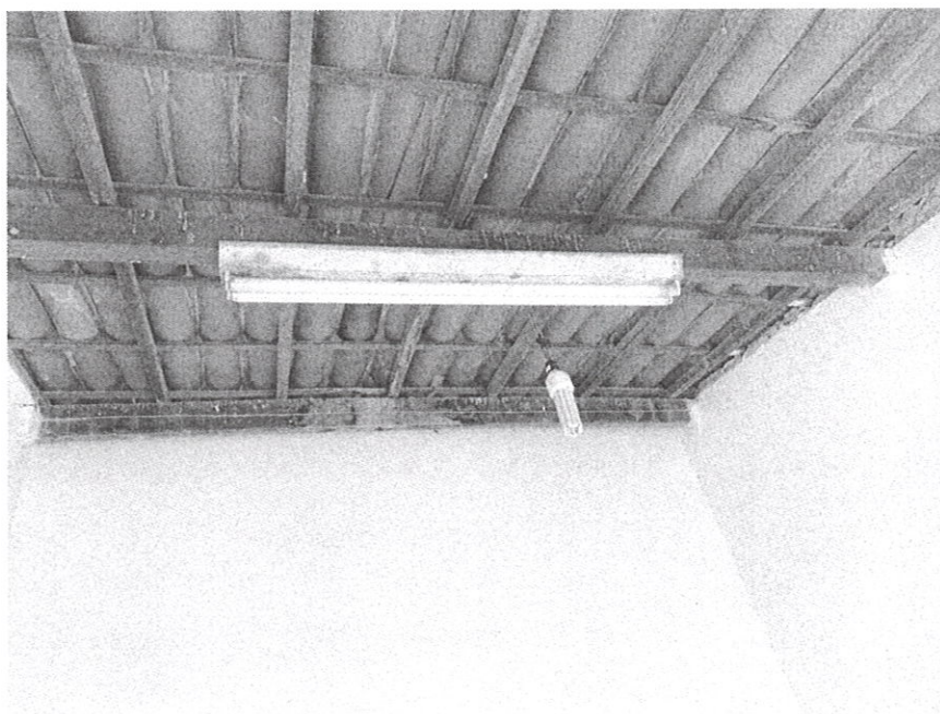
Foto 11- Colocação de Lâmpada Tubular
