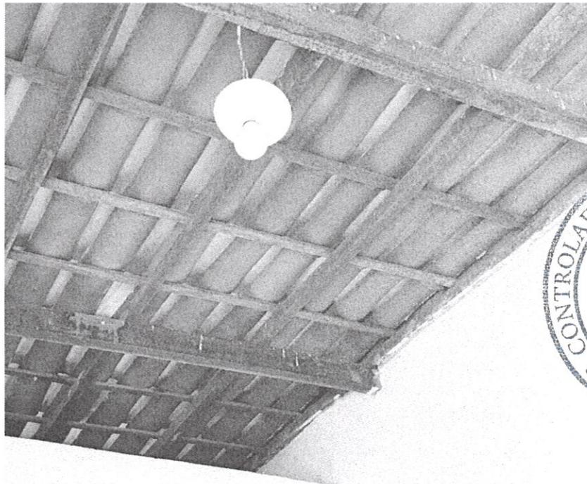
Foto 10 – Colocação de Luminária Tipo Plafon
