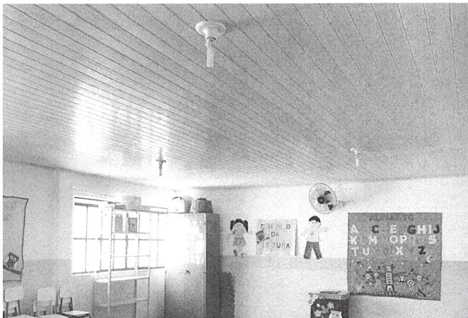
Foto 05- Revisão e Colocação de forro em PVC
