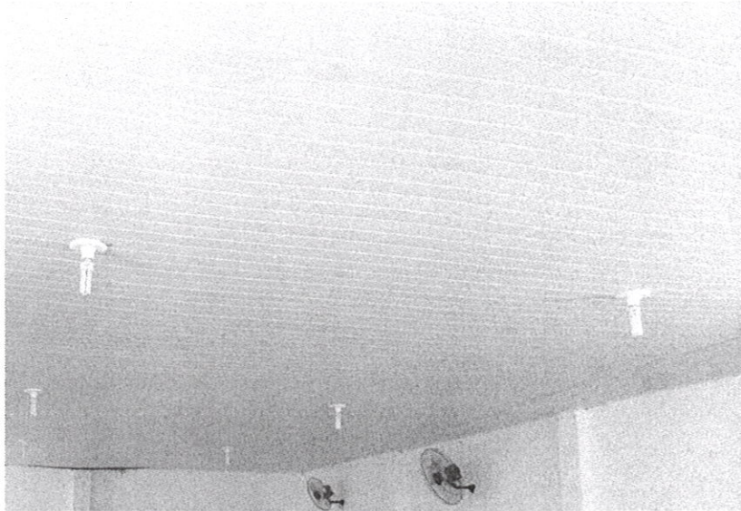
Foto 09 – Colocação de Luminária Tipo Plafon
