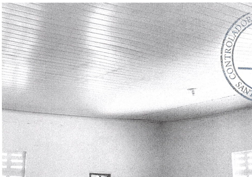
Foto 06- Revisão e Colocação de forro em PVC
