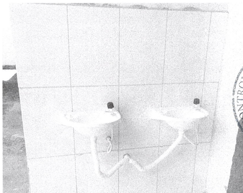
Foto 18- Colocação de Lavatório Louça Branca
