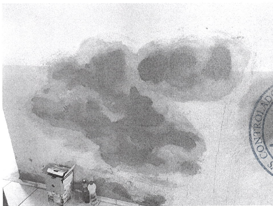
Foto 04- Reparo e reboco em superfície
